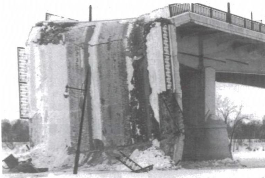
Figure VI.8 – Rupture du pont de Trois-Rivières (31 janvier 1951, Canada). La structure métallique s’est rompue fragilement par une nuit d’hiver ( -30^{\circ}\text{C} ), alors que le pont n’était que faiblement chargé.
